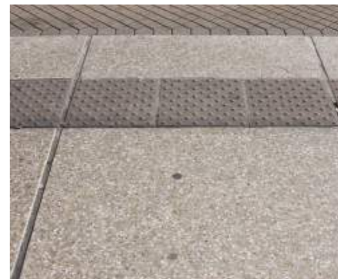
† Dalle de nez de quai en béton, finition polie, avec dalles pododactiles intégrées en béton. (Dalles limitées à la porte avant du bus)
